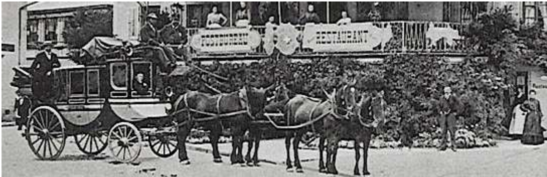
Abfahrt der Klausenpost vor dem Hotel "Tell und Post" in Flüelen.
