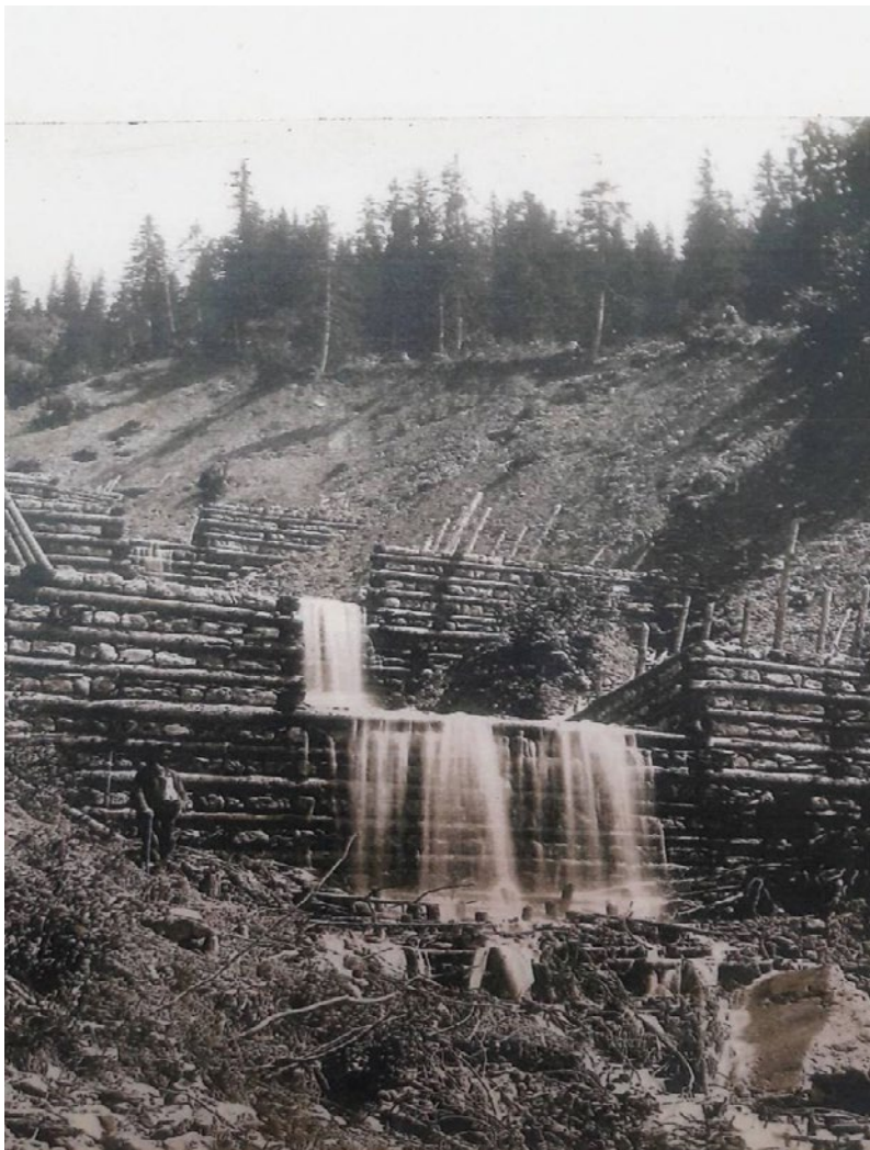
Holzkastensperren im Vorderbach ca. 1914
