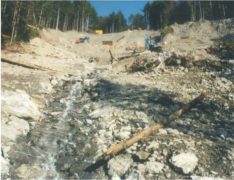
Foto 2: Rutschsanierung und Fassung der Bodmiquelle im Jahre 2003
