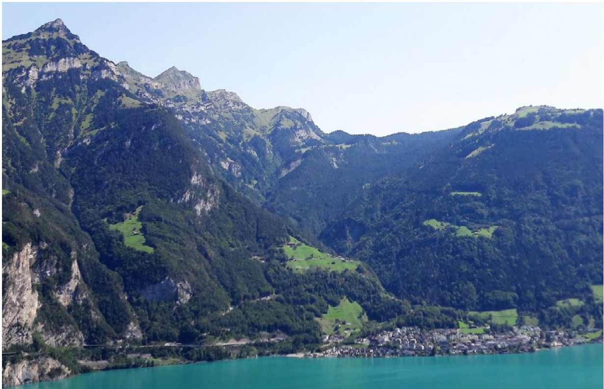
Unterer Bildrand: Usserdorf auf dem Ablagerungskegel des Gruonbaches
