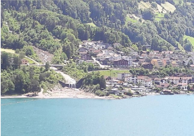
In Vordergrund Sammlerbereich mit Abschlussperre; im Hintergrund Axenstrasse und dahinter die Umlagerungsstrecke
