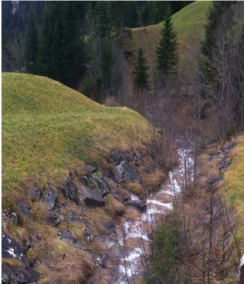
Umleitung des Guferlibaches zwischen Kote 1190 m ü. M. und Kote 1217 m ü. M. mittels einer 95 m langen Raubettgerinne
