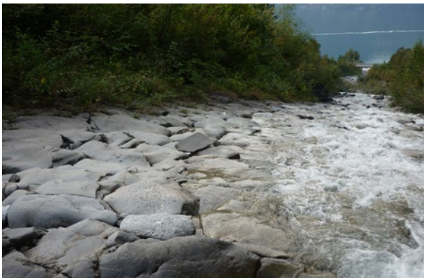
Schale zwischen der Kote 546 m ü. M. und der Einlaufsperre in die Umlagerungsstrecke oberhalb der Axenstrasse; Aufnahme 2014
