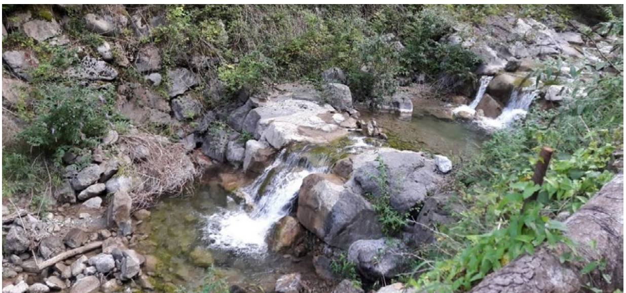
Blockrampe zwischen der Zeissigsperre und der Kote 546 m ü. M.; Aufnahme 2018
