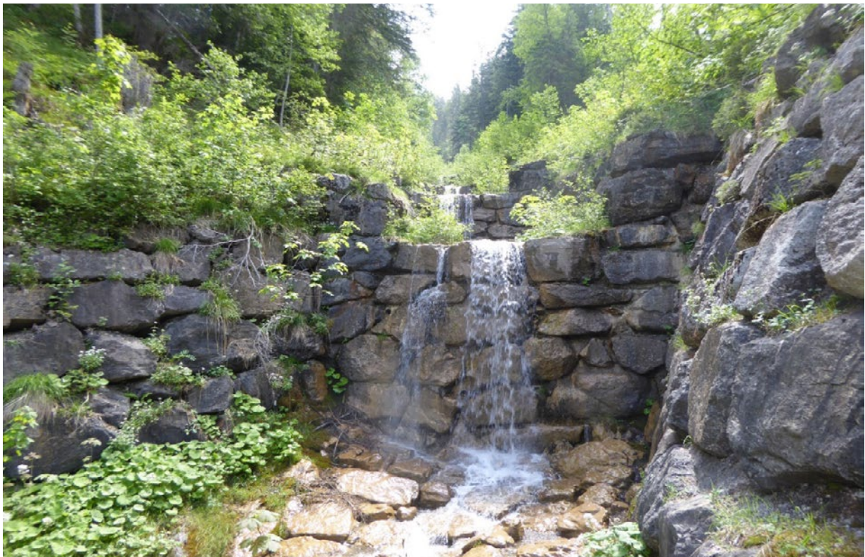
Steinblocksperrren im Vorderbach zwischen Gruonbergli und Kote 1243 m ü. M.; Aufnahme 2018
