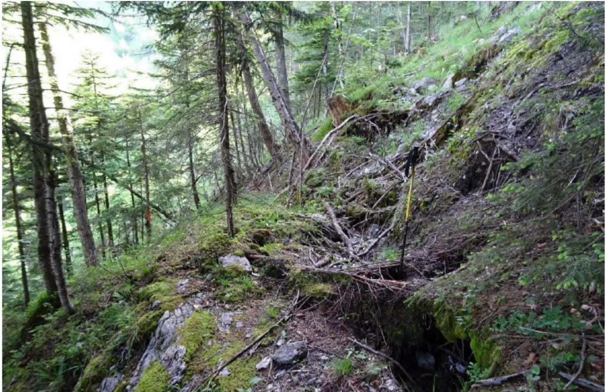
Foto 10: Vis-à-vis der Fluertüti rutscht der Hang südlich des Bodmibaches ebenfalls talwärts. Eindrücklich ist die obere Anrisszone auf einer Höhe von ca. 1160 m ü. M. direkt unterhalb der Zufahrtsstrasse ins Gebiet Chalt Brunnen.
