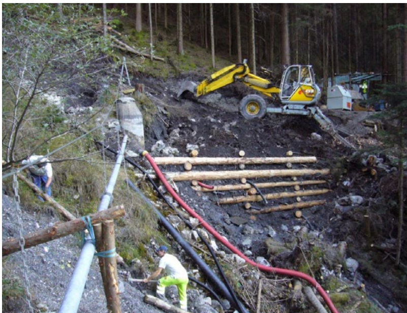
Foto 6: Sanierung Quelle Bodmi-Plätz im Oktober 2013
