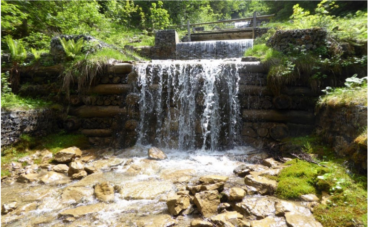
Holzkastensperre im Vorderbach, erbaut zwischen 1974 und 1984
