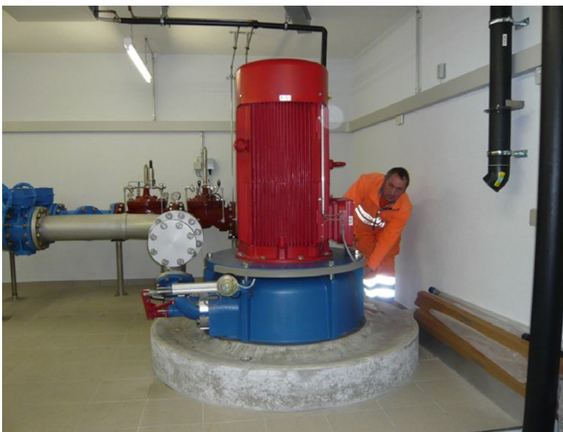
Foto 4: Druckbrecher Zeissig: Turbine zur Stromerzeugung und Brunnenmeister Franz Muheim
