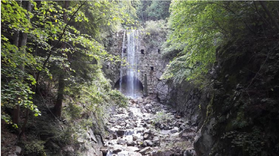
Zeissigsperre, Kote 580 m ü. M.; Aufnahme 2018
