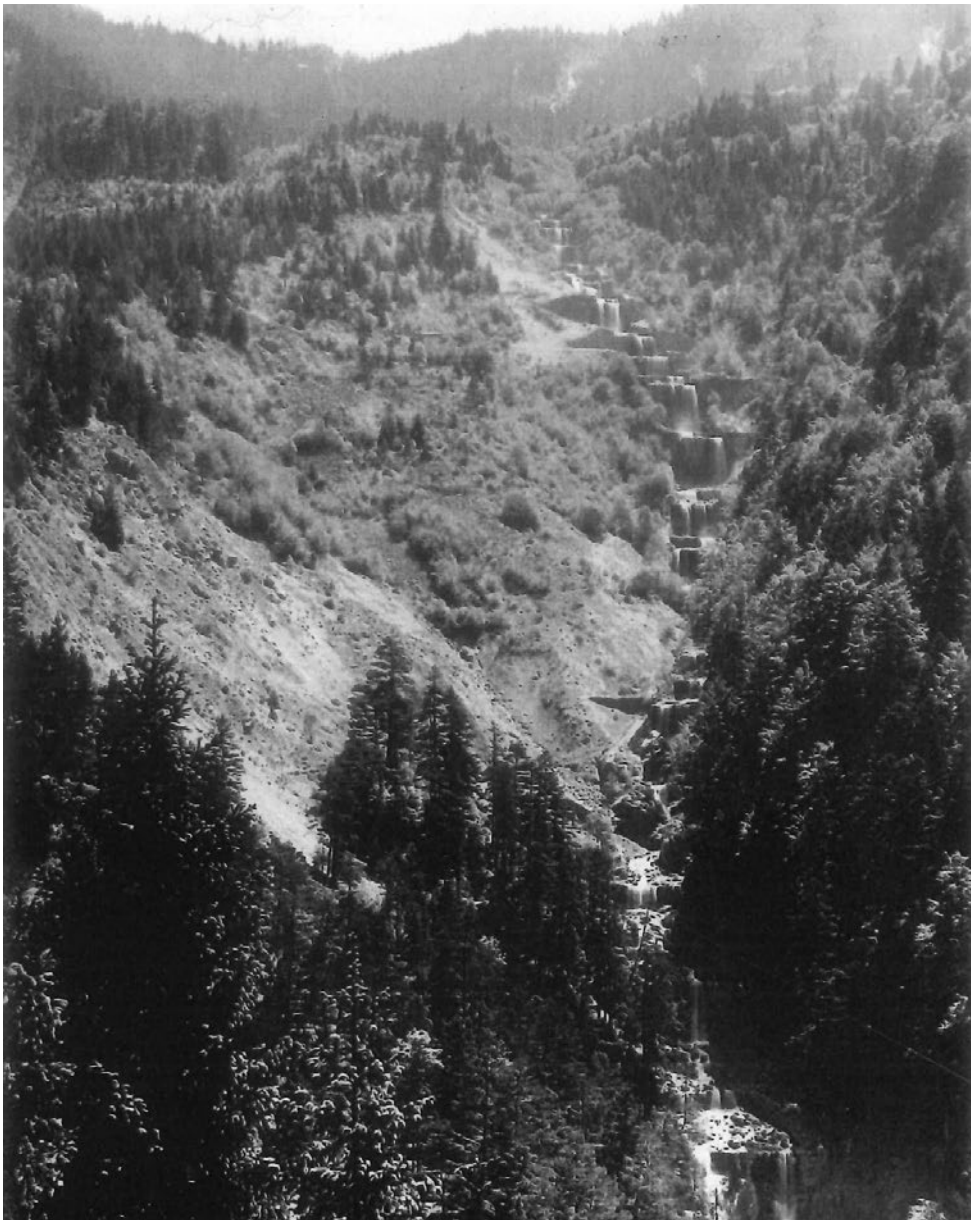
Sperrentreppe zwischen Föhrenegg und Gruonbergli 1982
